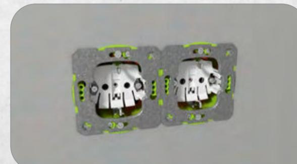
9. Geräte anbringen und dank der acht Schraubdomes flexibel ausrichten.
