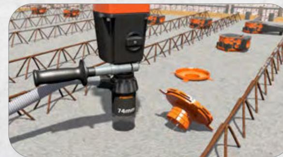
Mit dem Uni-Flexx können Spots, Lautsprecher oder andere Einbaugeräte auch noch nachträglich in die bereits gegossene Filigrandecke eingefügt werden. Die benötigte Kernbohrung ist viel kleiner und somit deutlich kostengünstiger als sonst üblich.
