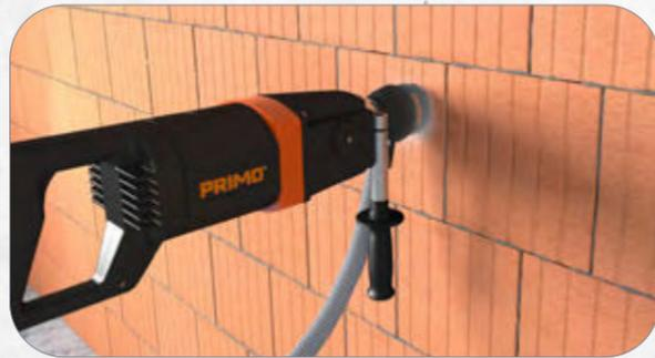
1. Erste Dose anzeichnen und mit Primo Schnellläufer und 82 mm Bohrkronen ausbohren.
