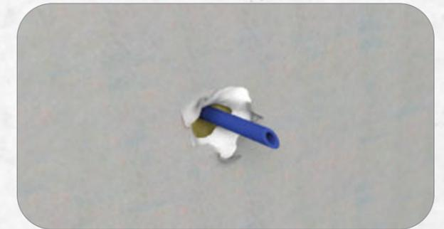
2. Angeschrägten Dorn durch zweite Gipskartonplatte drücken, ggf. vorher mit Hammer Loch einschlagen.
