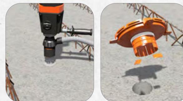
1. 74 mm Bohrung in Filigrandecke einbringen. Dazu eignet sich der Primo Schnellläufer. Installationssegmente bei Bedarf abtrennen, um die Einbautiefe der Deckenstärke anzupassen. Uni-Flexx anschließend ins Bohrloch stecken.
