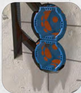
3. Bei einer verputzten Wand einfach den Putzanschlag abbrechen und Dosen komplett einführen.
