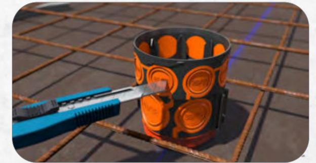
2. Membran mit Cuttermesser öffnen. Absolut betondichte Einföhrung durch Membrantechnik.
