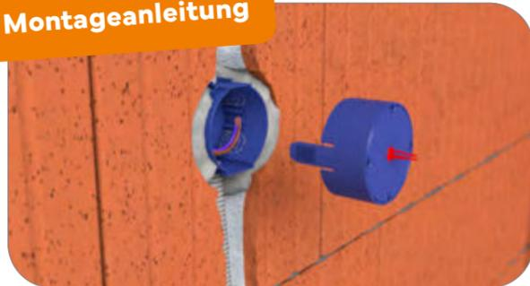
1. Unterteil bündig setzen, Kabel oder Rohre einführen. Standarddeckel mit ineinandergreifenden Rastzähnen vorsichtig einrasten lassen. Deckel ca. 2,5 – 3 cm hervor stehen lassen.
