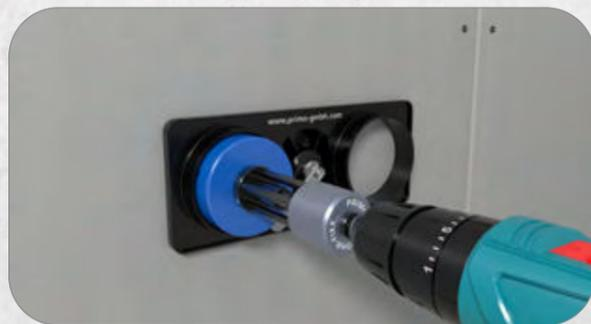
3. Für Mehrfachkombinationen Bohrschablone ins erste Loch einsetzen. Mithilfe der integrierten Wasserwaage ausrichten und den Hebel festspannen. Durch Versetzen der Schablone beliebig viele weitere Löcher im genormten Abstand von 71 mm bohren.
