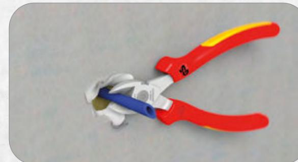
3. Leitungsträger mit Zange bündig zur Wand abzwicken.
