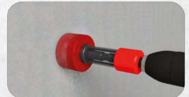
4. Dosenfräser im Zentrierbohrloch ansetzen und Loch ausfräsen.
