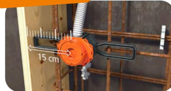
Löcher für Installationsrohre mit einer Stanzzange ausstanzen oder mit einem Stufenbohrer ausbohren. Rohre M20/M25 oder M32 einführen. Flügel geben 15 cm Normabstand zur Türschalung vor.
