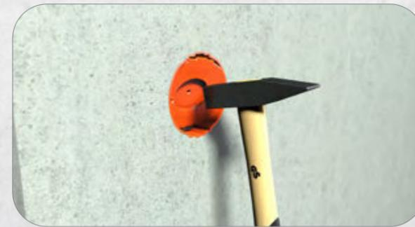
5. Nach der Betonage einfaches Öffnen durch Hammerschlag.
