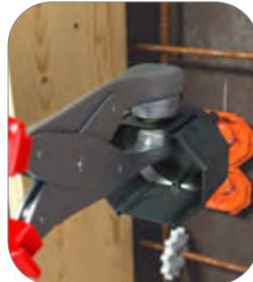
Löcher für Installationsrohre M20/M25 mit einer Stanzzange ausstanzen. Löcher für Installationsrohre M32 mit einem Stufenbohrer ausbohren. Installationsrohre einführen. M20/M25 und Großrohreführung M32 möglich.
