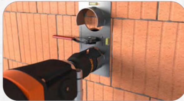
2. Für Mehrfachkombinationen Bohrschablone ins erste Loch einsetzen. Den Hebel festspannen & mithilfe der integrierten Wasserwaage ausrichten. Durch Versetzen der Schablone beliebig viele weitere Löcher im genormten Abstand von 71 mm bohren.
