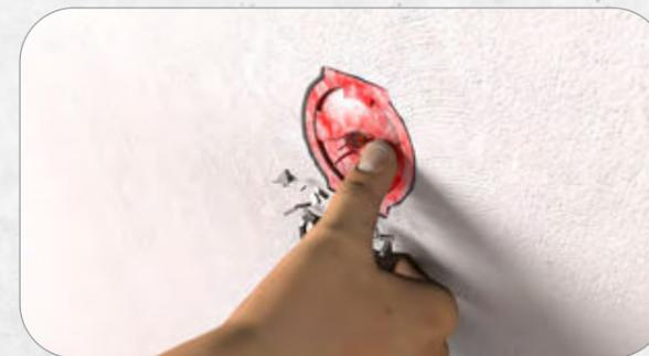
9. Putzfedern sorgen für schnelles Auffinden. Den Deckel mit dem Finger oder Schraubenzieher eindrücken. Wenn er nach außen ploppt, entsteht eine saubere Kontur ohne Sprünge im Putz. Anschließend Deckel entfernen.
