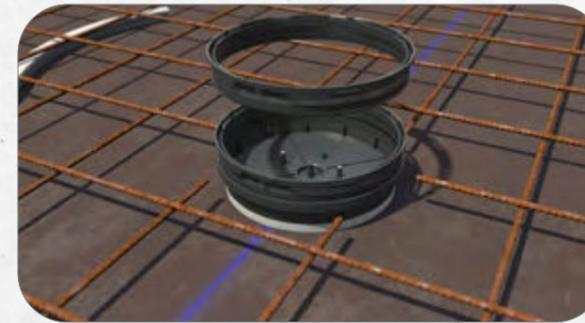
**Verlängerungsring(e)** auf das Frontteil stecken. Ein Verlängerungsring erweitert die Tiefe um 20 mm und garantiert mehr Installationsraum. Es können mehrere Verlängerungsringe miteinander kombiniert werden, bis die gewünschte Einbautiefe erreicht ist.
