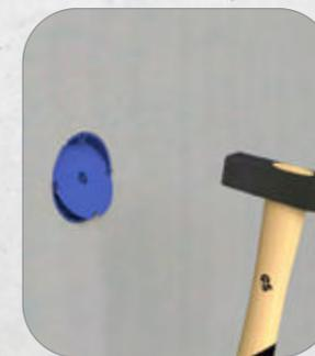
11. Deckel mit einem Hammer ausbrechen.
