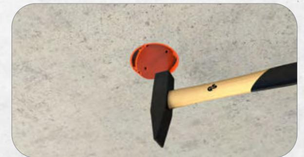
4. Dose mit Deckel schließen und Decke betonieren. Frontteil nach der Betonage mit Hammer einschlagen.
