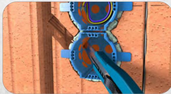
6. Alternativ die Membrane mit dem Cuttermesser öffnen.
