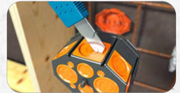
2. Membrane mit einem Cuttermesser öffnen. Großrohreführung M32 vorhanden.
