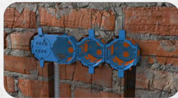
2. Dosen bis zum Putzanschlag einführen. Damit ist die normgerechte und putzbündige Installation gewährleistet.
