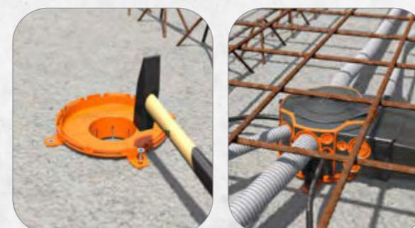
2. Löcher durch Montagelaschen bohren und Uni-Flexx mit Schlagdübeln auf der Decke befestigen. Einbaugehäuse XL 150 aufsetzen. Membran mit Cuttermesser öffnen, um Kabel und Rohre einzuführen.
