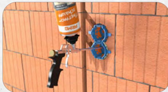
4. Mit der Schaumpistole den Schaum durch die Öffnung im Hintern der Dose einspritzen, bis die Dose luftdicht und wärmebrückenfrei vollständig umschlossen ist. Nach 20–30 Minuten ist der Schaum schnittfest.
