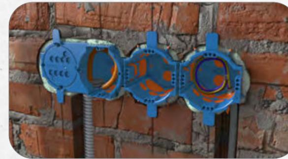
5. Kabel durch den Cable-Plopp durchstechen und so komplett werkzeuglos einführen.
