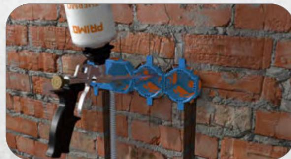
4. Mit der Schaumpistole die Sollbruchstelle im Hinteren der Dose ausbrechen und den Schaum einspritzen, bis die Dose vollständig umschlossen ist. Nach 30 Minuten ist der Schaum schnittfest.
