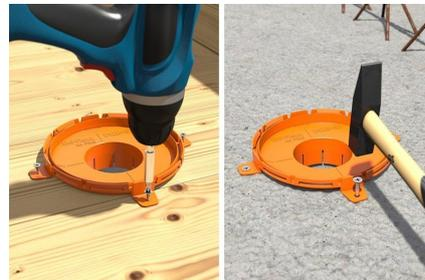
Uni-Flexx mit Schrauben oder Montagelaschen befestigen.
