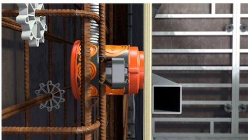
Flexible Flügel passen sich der jeweiligen Betondeckung an. Betondeckungen zwischen 20-40mm oder 40-60mm.
