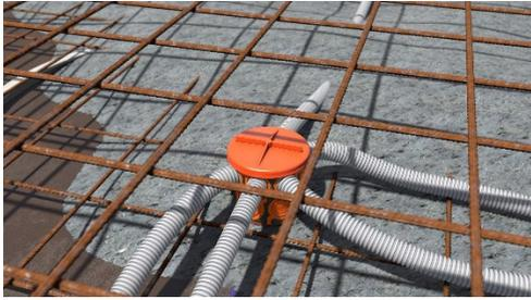
Deckel mit Handgriff schließen, Stahlarmierung legen und betonieren.
