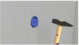
Deckel mit Hammerschlag ausbrechen und Einbaugerät / Steckdose installieren
