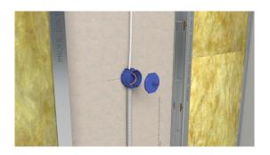
Bohrdeckel (P003) aufstecken und Dämmwolle einlegen.
