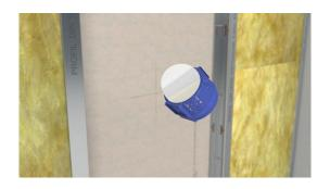
Klebescheibe (P005) auf das Unterteil kleben, Schutzfolie abziehen.
