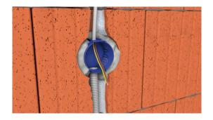
Bohrloch für Dosenunterteil fräsen. Dosenunterteil bündig setzen, Leitungen und Rohre einführen.
