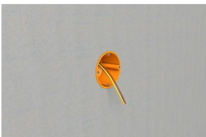
Hohlwanddose montieren, Einbaugerät oder Steckdose installieren.
