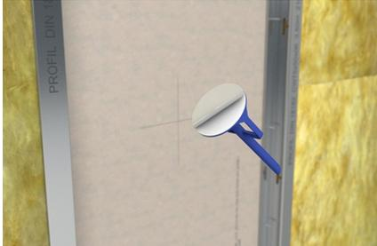
Klebescheibe auf Leitungsträger kleben und Schutzfolie abziehen.
