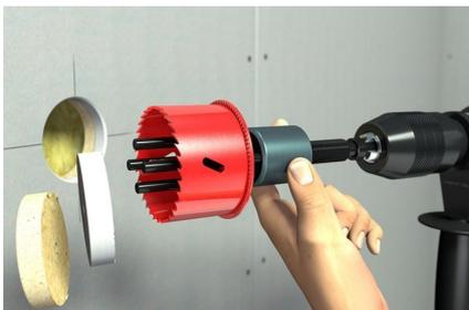
Dosenfräser im Zentrierbohrloch ansetzen und Loch ausfräsen.
