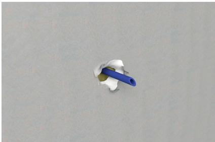
Angeschragten Dorn durch zweite Gipskartonplatte drücken, ggf. vorher mit Hammer Loch einschlagen.
