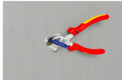
Leitungsträger mit Zange bündig zur Wand abwickeln.
