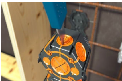
Membrane mit einem Cuttermesser öffnen.
