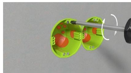
Dosen in die Bohrlöcher einsetzen und die Schrauben festziehen.
